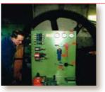
Durante l'inverno 1982-1983 vennero eseguiti lavori di notevole impegno, anche finanziario. Il personale della funicolare eseguì opere di consolidamento lungo la linea (traversine e muri di sostegno), mentre le ditte Kündig e Garaventa provvidero alla sostituzione dei dispositivi di comando e di regolazione dell'impianto elettrico di trazione con un nuovo moderno impianto elettronico. Il comando freni meccanico venne sostituito con un nuovo comando freni idraulico.
